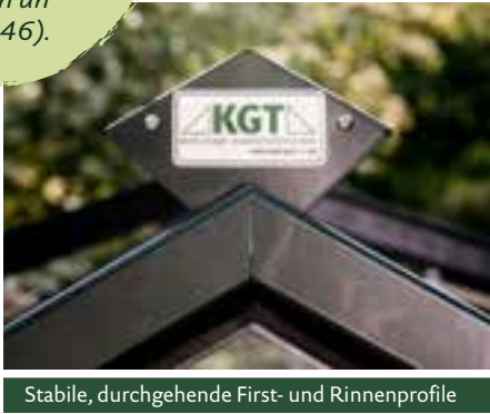
Stabile, durchgehende First- und Rinnenprofile
